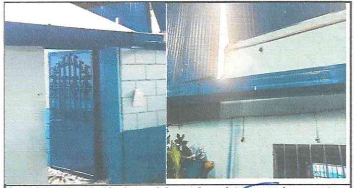
Suministro e instalación de canal de metal, se pintaron canales y puertas, se instaló vidrios a puerta de Párvulos 2
