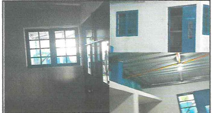
Foto 4: Remozamientos de paredes de cocina, suministro e instalación de tubería de agua e instalación de sistema eléctrico. Se instalaron 2 balcon ventana con vidrio, 1 puerta de 2 hojas
