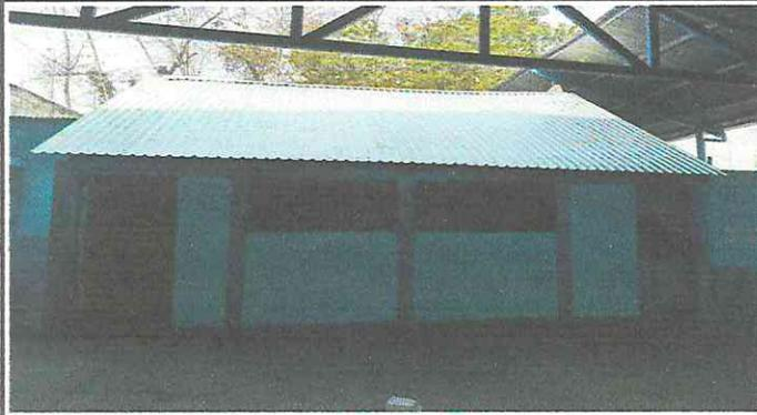
Foto 1: Sustitución de lámina dañada por lámina troquelada aluzinc calibre 26
