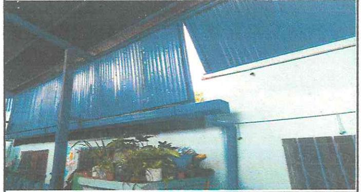
Foto 2: Cubierta de lámina con estructura galvanizada y lámina reutilizada pintada.
